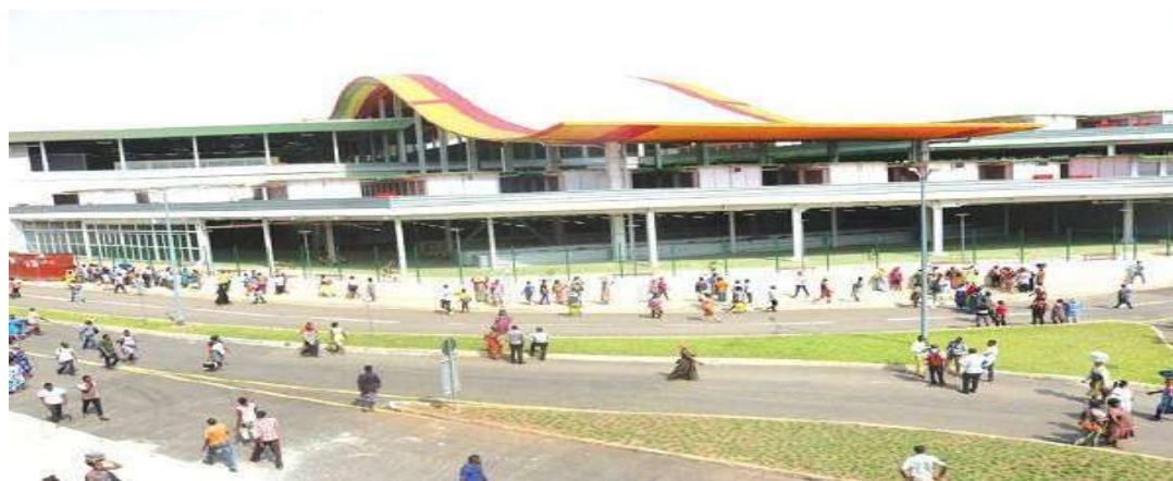
Image 2.5 Déploiement d'infrastructures numériques (TIC)
