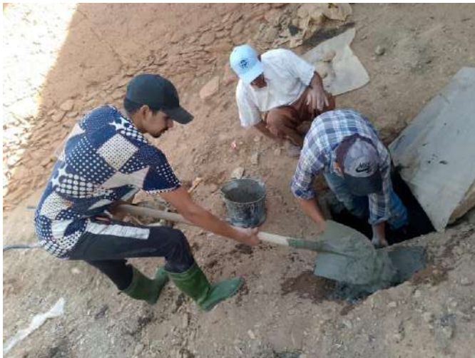
Photo: Remplacement des anciens couvercles détériorés
