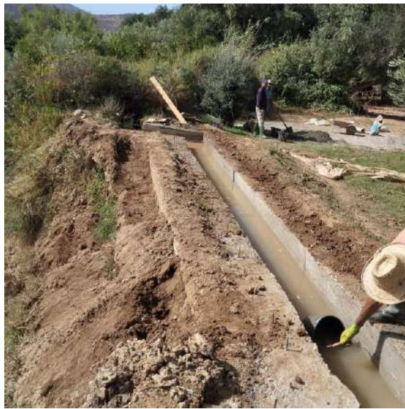
Photo: Travaux de reconstruction des tronçons de la rigole principale de la fraction d'Adouz
