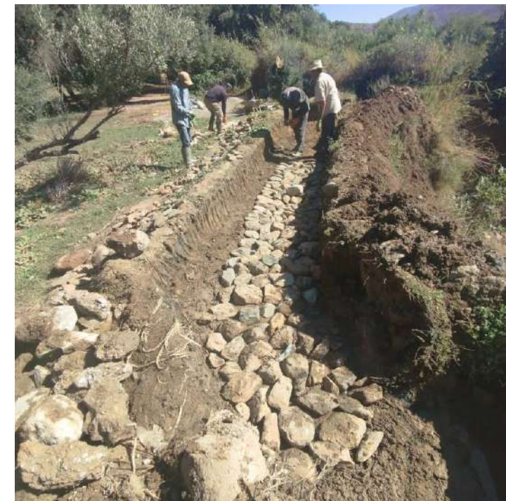
Photo: Travaux de préparation de la rigole avant de mettre le coffrage en béton armé
