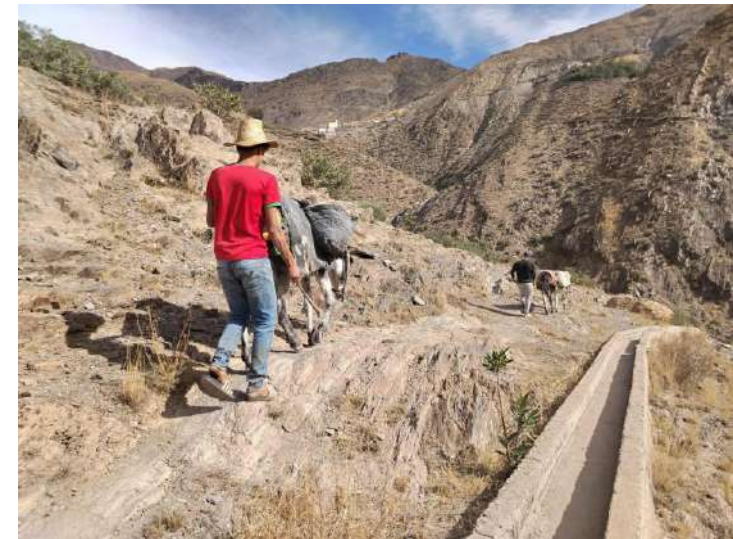
Photo: Acheminement du matériel de construction (ciment, sable, etc.) vers le site du travail à l'aide d'animaux de trait.
