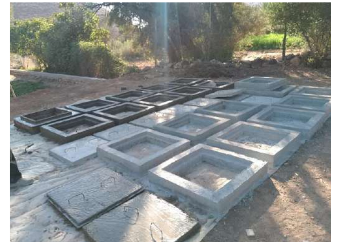
Photo: Chantier de fabrication des nouveaux couvercles des regards
