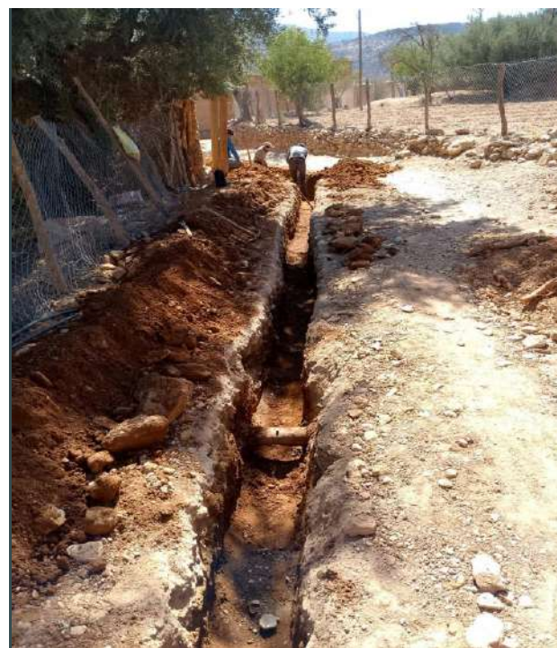
Photos: Travaux de rehabilitation et extension du réseau d'assainissement liquide
