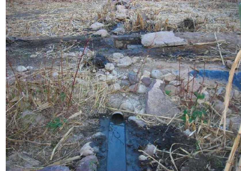
Photo : Évacuation des eaux usées en pleine nature, suite au débordement du réseau principal
